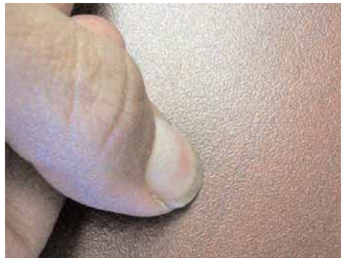
Figure 6.4.8 Lisser la cire avec un ongle
