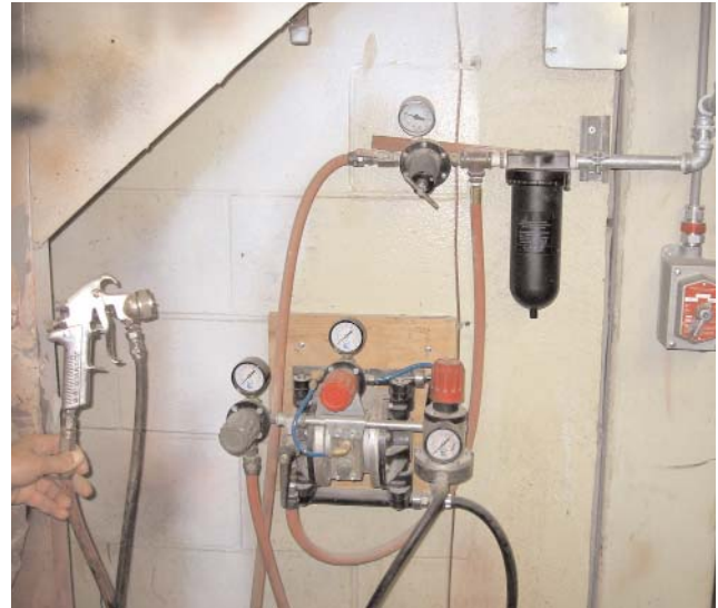
Figure 2.2.11 Système de vaporisation à membrane
